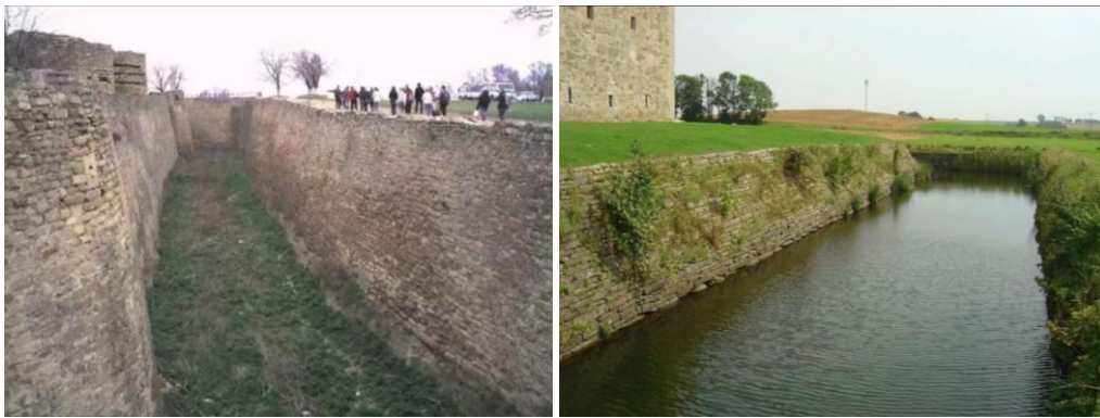
Рис. 3. РОВ сухой и заполненный водой.
