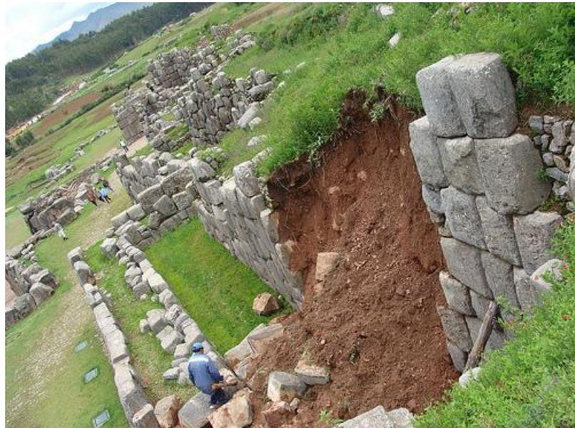
Рис. 6. Часть внешней облицовки обрушилась, обнажив внутреннее заполнение.
