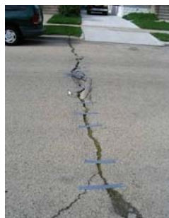
Cum să repară crăpăturile din asfalt
