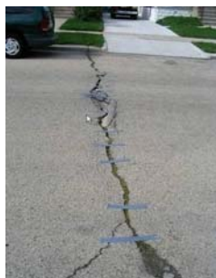
Cum să repară crăpăturile din asfalt
